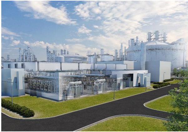
Darstellung der zukünftig am Standort der BASF in Ludwigshafen integrierten Wasserelektrolyse, die in Kooperation mit Siemens Energy errichtet wird. Die Anlage, das sogenannte Hy4Chem-EI-Projekt, wird eine Kapazität von bis zu 8.000 Tonnen Wasserstoff pro Jahr besitzen. Bildrechte: Siemens Energy
